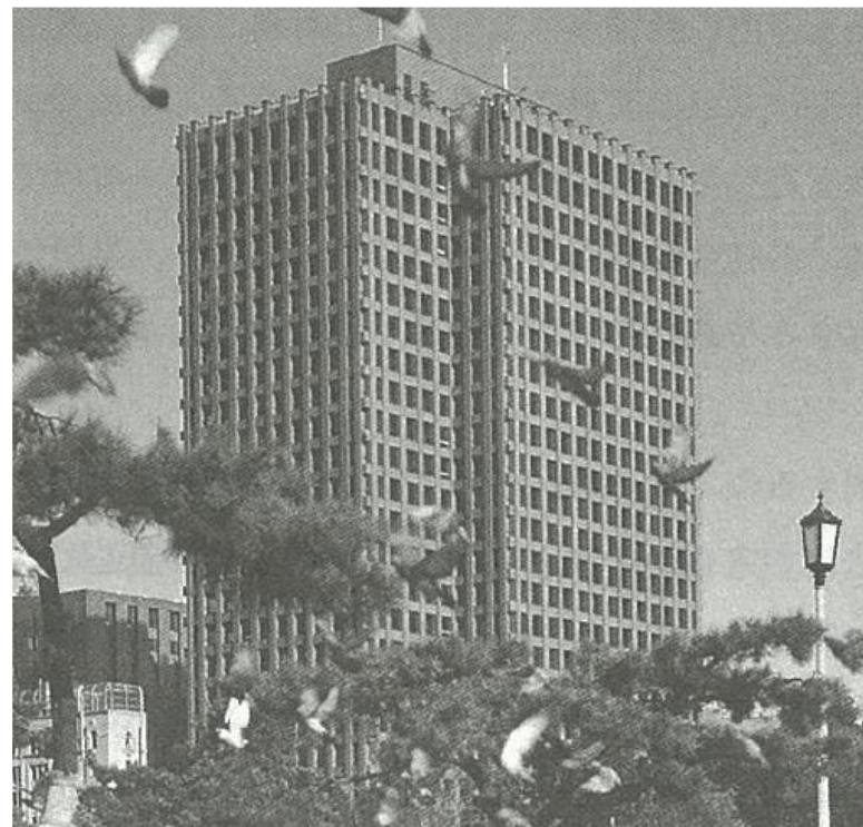
建替え後の東京海上ビル
