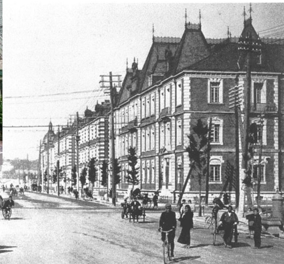
場先通り 第3号館(左端)となりの第12号館(明治43年竣工)は工事中。
